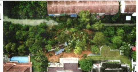
Kedudukan kawasan kejadian tanah runtuh di Kemensah Heights, Hulu Klang
