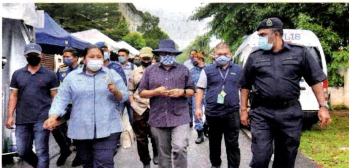
Dr Latiff (dua dari kiri) melawat lokasi kejadian tanah runtuh di Jalan Kemensah Heights pada Sabtu.
