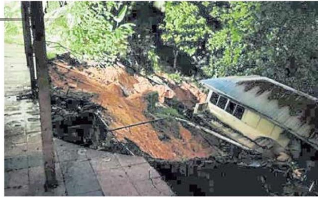
■其中一间屋子因泥土倾泻导致坍塌滑落。(图由消防局提供)
